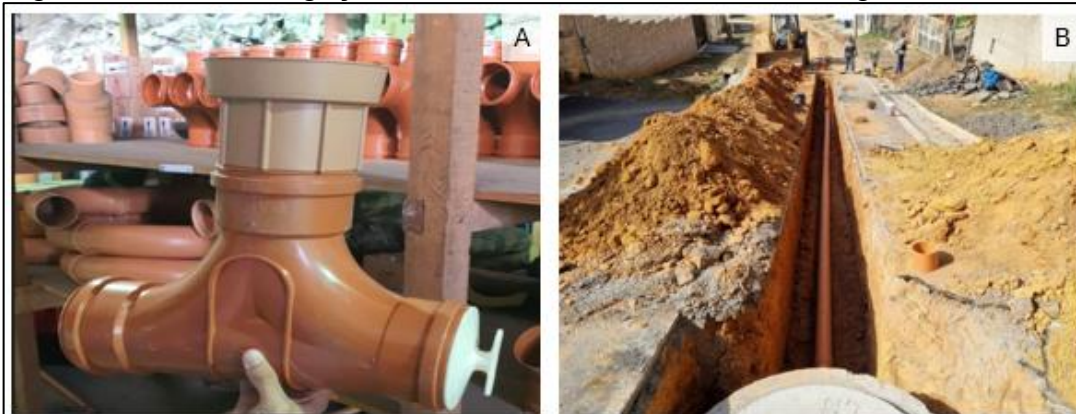
Figura 1 - Ponto de ligação domiciliar e Rede coletora de esgoto
