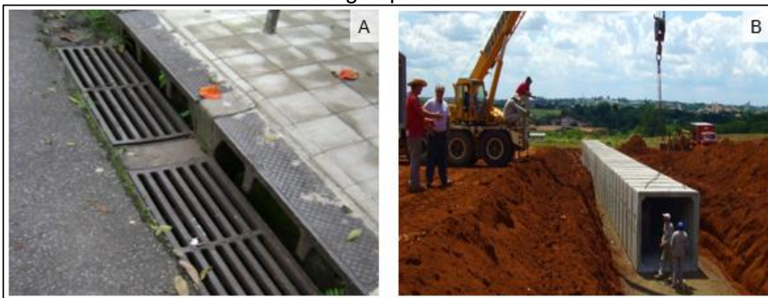
Figura 3 - Boca de lobo e Galeria de água pluviais
