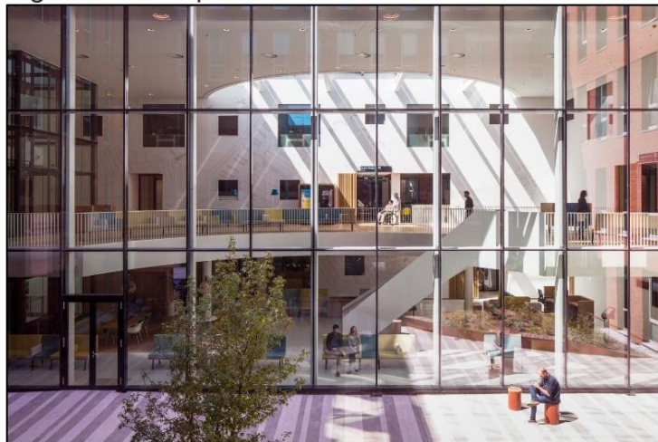
Figura 4 – Hospital Zaans Medisch Centrum
