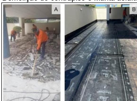
Figura 4 – Demolição do contrapiso e Manta asfáltica aplicada
