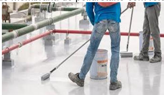
Figura 2 – Aplicação de membrana de poliuretano com rolo em cobertura exposta
