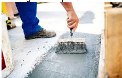
Figura 1 – Aplicação de argamassa polimérica em superfície de concreto
