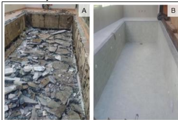
Figura 6 – Demolição do revestimento e Piscina revestida
