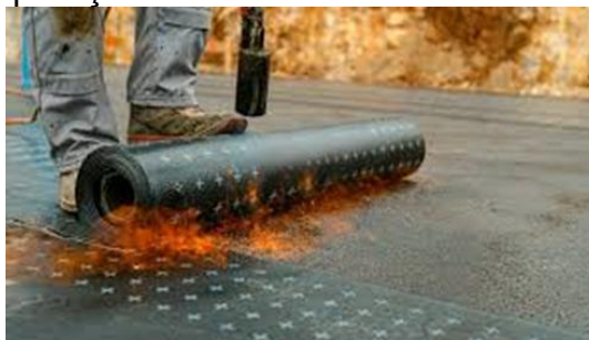
Figura 3 – Aplicação de manta asfáltica com uso de maçarico
