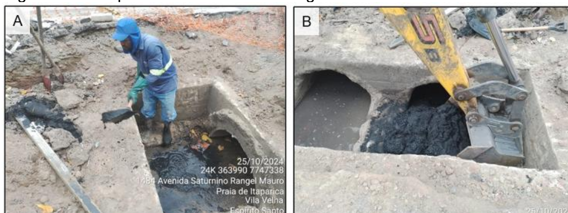
Figura 10 – Limpeza do sistema de drenagem
