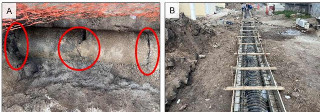
Figura 07 - Trocas de tubos de concreto por PEAD
